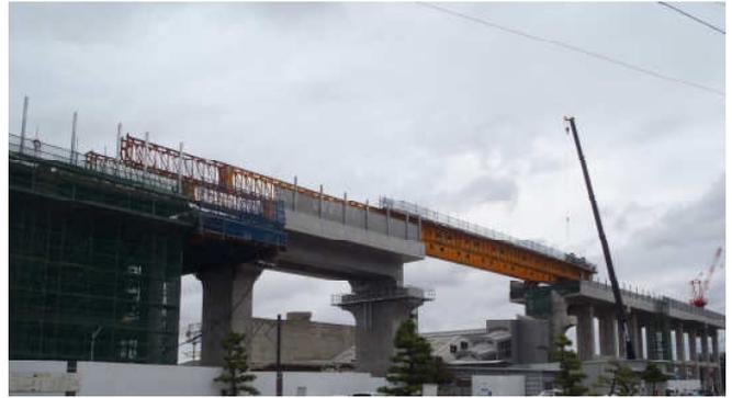
写真-2 架設桁施工状況
