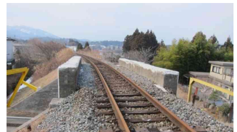
写真-1 橋りょう断面(拡幅前)
