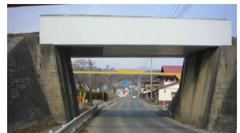
写真-2 橋りょう側面(拡幅前)
