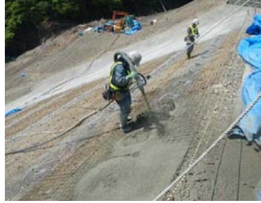
写真-3 吹付け状況
