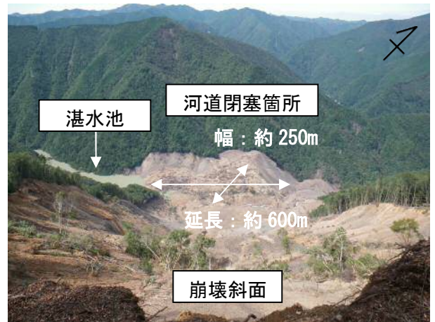
写真-1 河道閉塞状況
