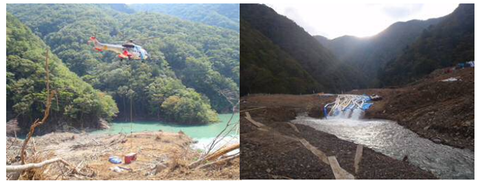
写真-2 ヘリコプタによる資材搬入・ポンプ排水状況
