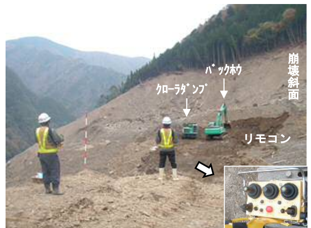
写真-3 防護土堤無人化施工状況
