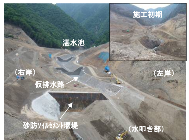
写真-4 仮排水路施工完了（水叩き部除く）
