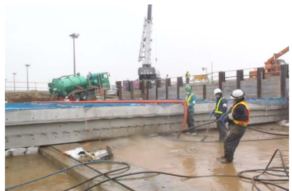
写真-3 頂版砂型枠洗い流し状況
