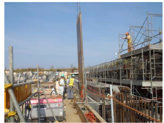
写真-2 側壁鋼製パネル型枠撤去状況
