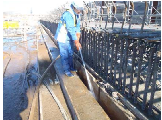
写真-1 側壁砂型枠洗い流し状況
