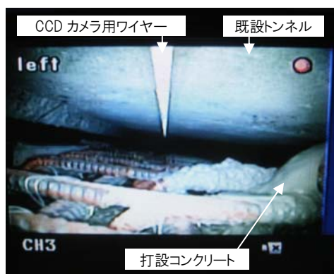
写真-1 CCD カメラによる桁内部の映像
