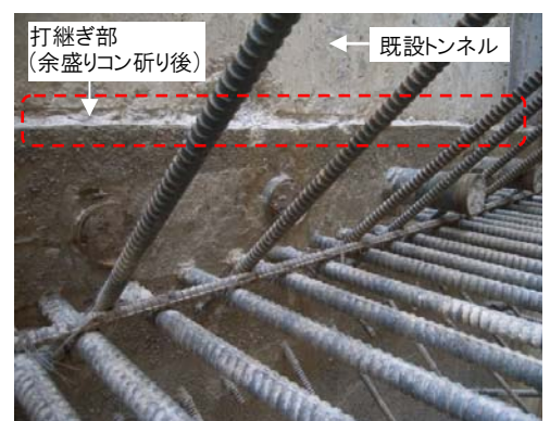
写真-3 境界部仕上がり状況
