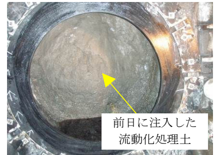
写真-7 鋼管引抜完了時の鏡面
