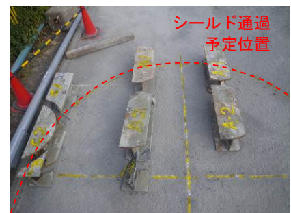
写真-9 回収したH鋼杭の配置
