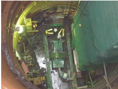
写真-5 作業状況
