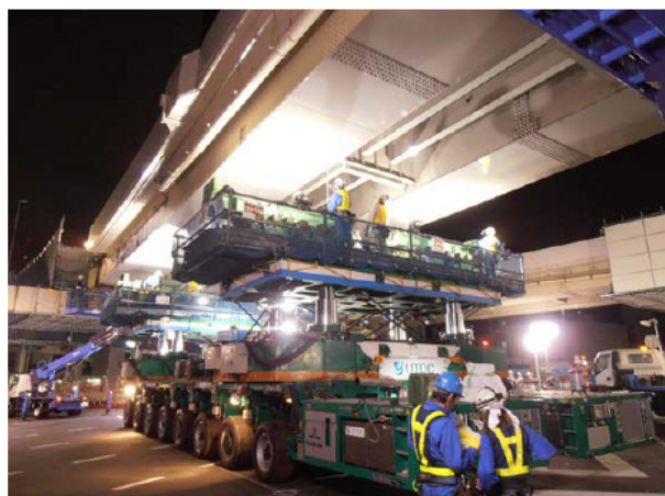
写真-1 多軸台車を用いた桁受け作業状況
