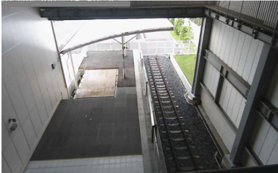
図3 試験現場の状況
