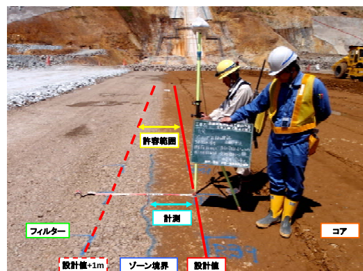
写真-1 ゾーン境界出来形計測状況
