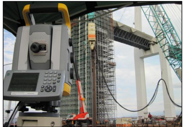
写真-1 TSによる自動追尾状況
