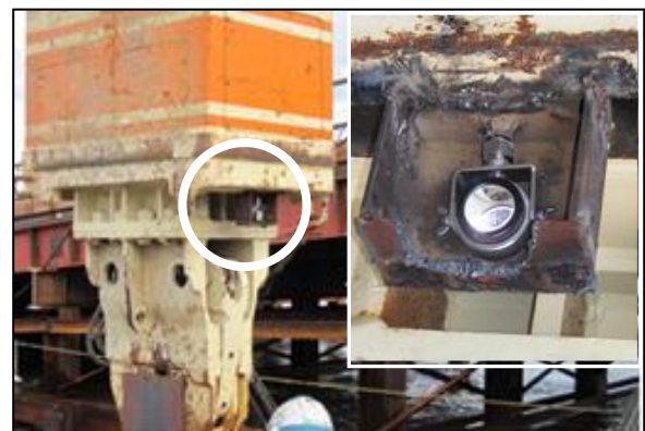
写真-3 プリズム固定状況
