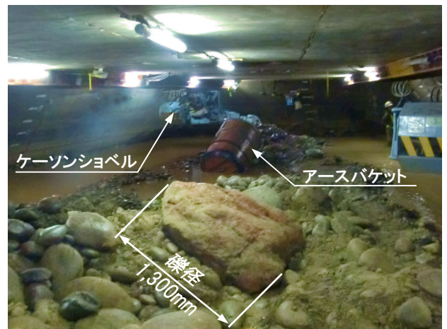
写真-1 掘削状況写真
