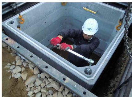
図-4 トルクレンチによる締付け状況
