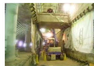
図10 シールドトンネル切上げ工施工状況
