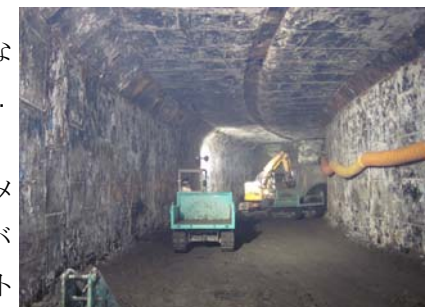
写真-2 内部掘削状況
