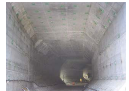
写真-4 躯体完成
