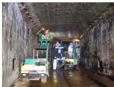
写真-3 セグメント撤去状況
