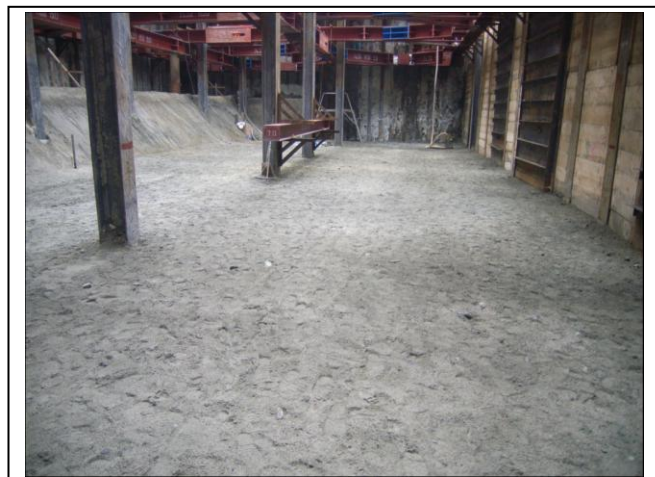
写真-1 最終掘削時の床付面状況
