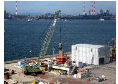
写真-3 掘削状況(坑外)
