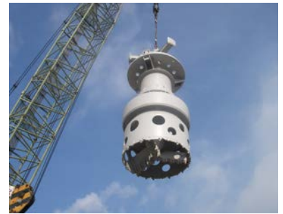
写真-2 パイプドリル(芯抜き用)
