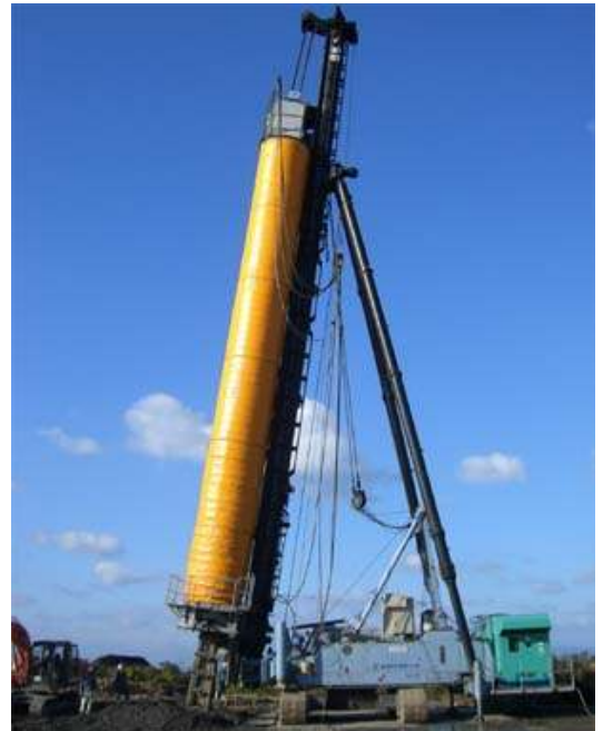
写真-2 ソイルセメント傾斜壁の施工状況
