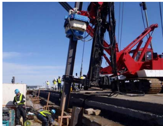
写真-2 中型三点式杭打機+CHV
