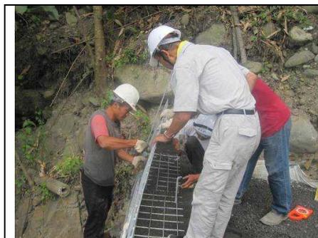
図-4 鋼製枠組立
