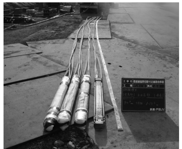
図-2. 支圧式アンカー写真
