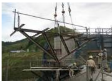
写真－2 ブラケット据付
