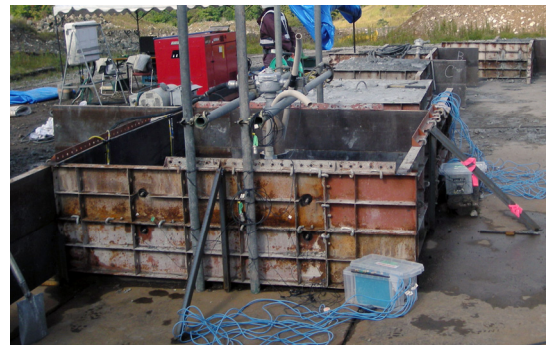
図-2 試験体組立状況
