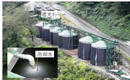
写真－2 遮光ネット, 散水冷却
