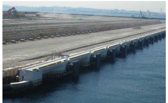
図-1 MC-3岸壁全景
