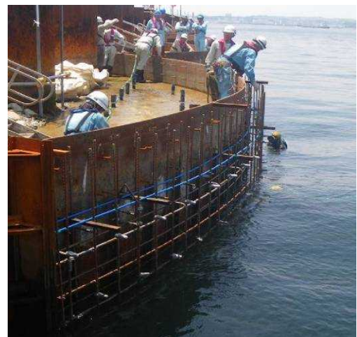
図-6 ステンレス鉄筋の設置状況
