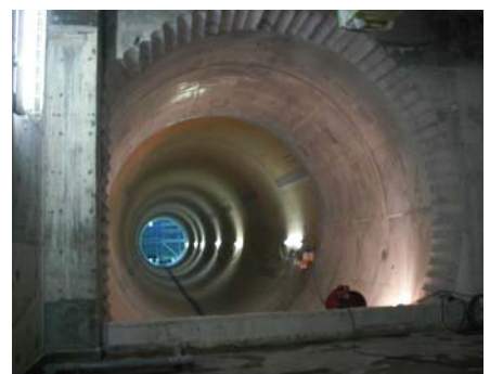
写真-2 東館接続状況
