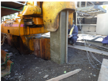
図-6 施工性確認実験
