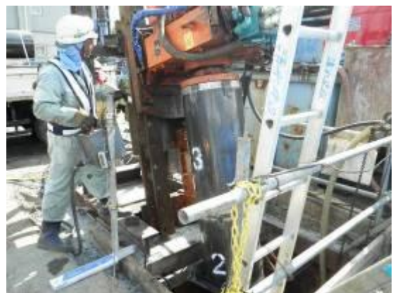
図-4 ボーリング状況
