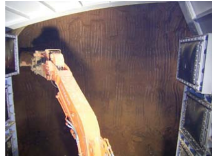
写真-2 切羽地山状況
