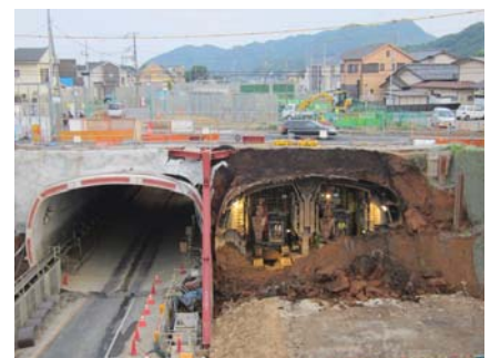
写真-5 下り線シールド到達状況
