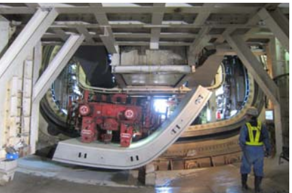
写真-2 セグメント組立状況
