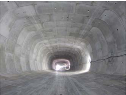
写真-3 トンネル坑内完成
