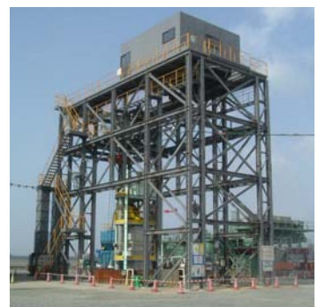
写真-2 堅坑上部の櫓
