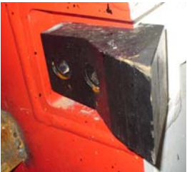
写真－１ 再利用ビット取付状況
