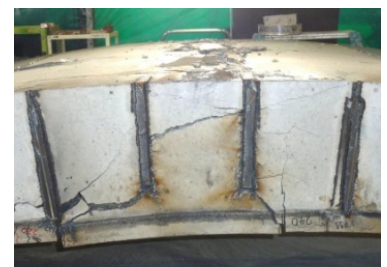
写真 2. Case-5 の破壊状況
