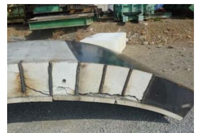
写真 1. Case-4 の破壊状況
