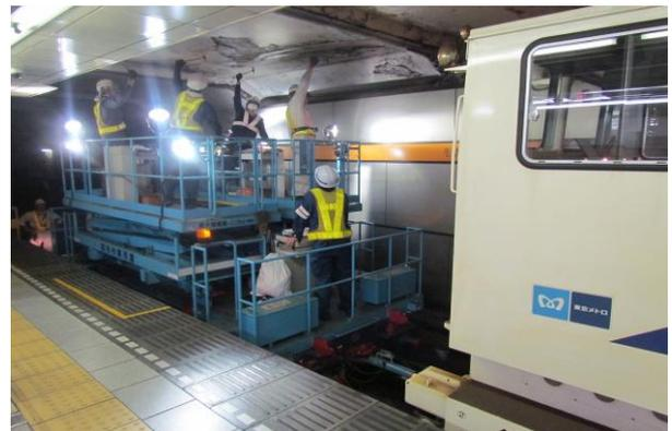
写真-1 高所作業車および検査状況
