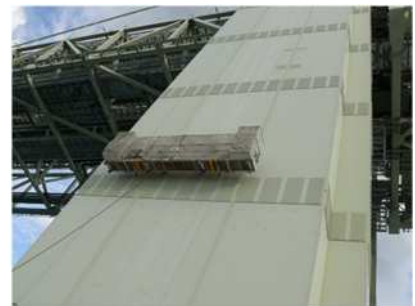
写真-4 ゴンドラによる近接調査
