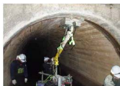
図-2 背面空洞調査状況
