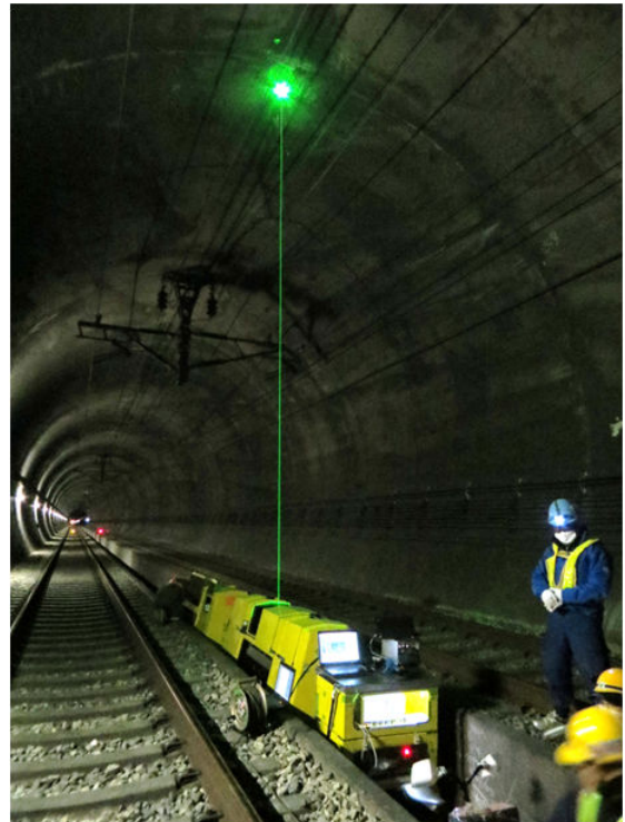
図3 新幹線トンネル内での検査の様子
