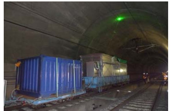
図5 新幹線トンネル内のレーザー探傷装置
