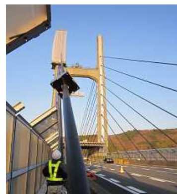
写真-2 実斜材の調査状況
