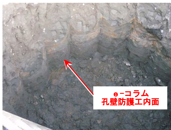
写真-1 e-コラム防護壁掘り出し状況
