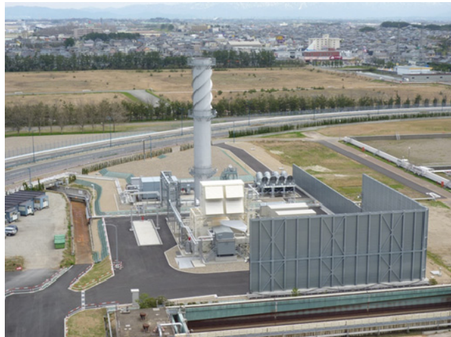
写真-1 新潟火力発電所6号機
