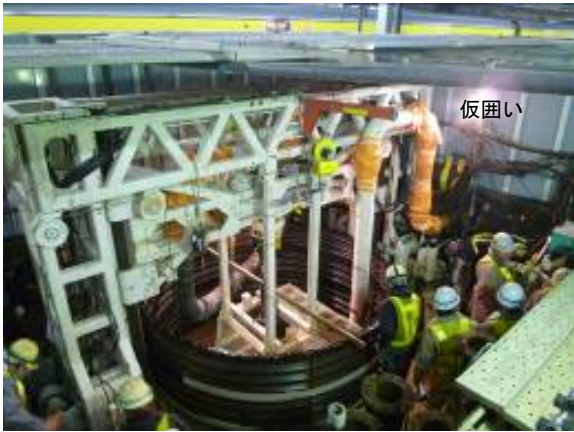
写真-1 ホーム部での施工状況
