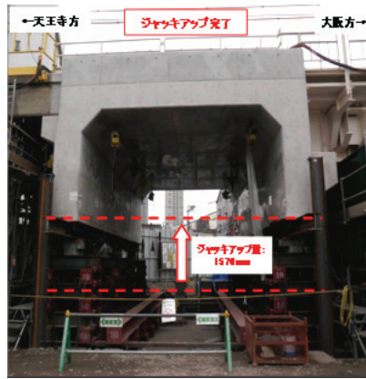
写真2 ジャッキアップ後
