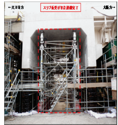
写真3 スラブ仮受台支保工
