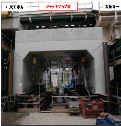
写真1 ジャッキアップ前
