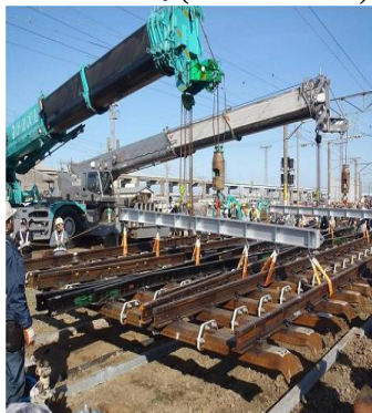
写真-2 新分岐器挿入
