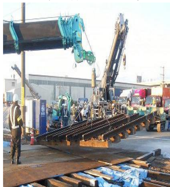
写真-1 旧分岐器撤去
