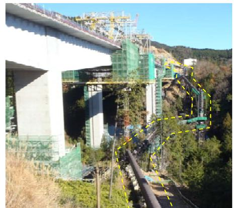
写真-2 ベルトコンベア状況 (点線範囲がベルトコンベア)
