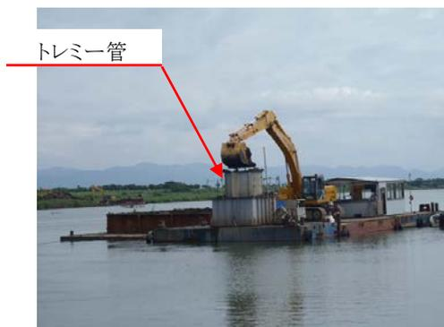
写真-1 トレミー管土砂投入状況
