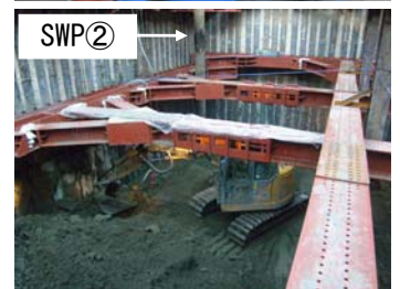
写真1 真空排水状況(上) 5次掘削状況(下)
