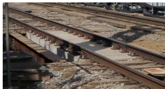
写真 1 架設済みの PC 工事桁
