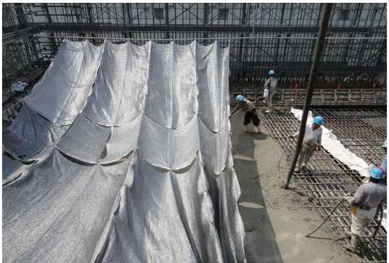
写真-1 遮光シート設置状況
