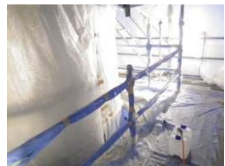
写真-1 加湿養生状況
